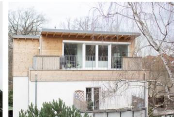
wurde die Aufstockung mit Wänden in Holzrahmenbauweise errichtet, die im Werk gebaut und vor Ort montiert wurden. Damit ist die Bauzeit deutlich verkürzt. Selbst die Fassade wurde ab Werk fertig montiert geliefert.
